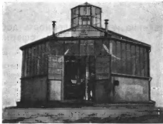
Фиг. 10. „Windenhause“ Линденбергской Обсерваторіи, изъ котораго производятся подъемы змѣевъ и привязныхъ шаровъ.
